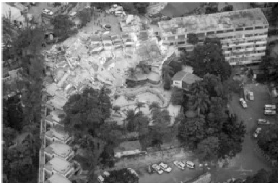
Foto: QG da ONU destruído em Porto Príncipe (Arquivo CCOPAB)
